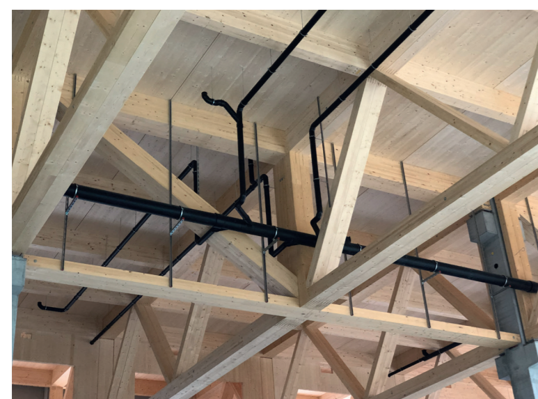
> Anschluss der Nebenfachwerke an die Hauptfachwerke mittels schleifender Schlitzblech-Stabdübel-Verbindung
