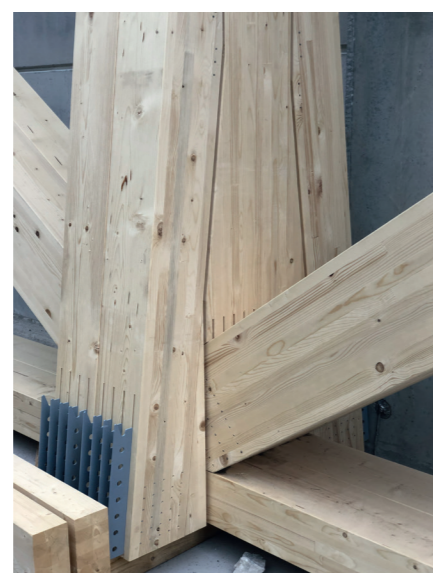
> Anschluss der Nebenfachwerke an die Hauptfachwerke mittels schleifender Schlitzblech-Stabdübel-Verbindung
