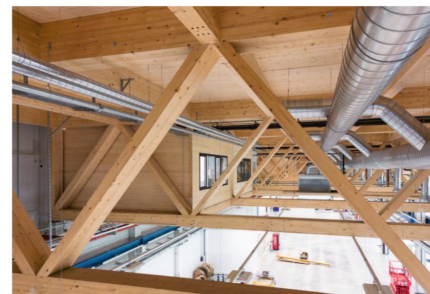
> Holztragwerk mit Büro-Zwischengeschoss
