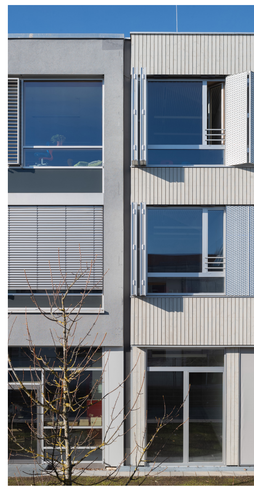
Übergang von Bestand zu Neubau
