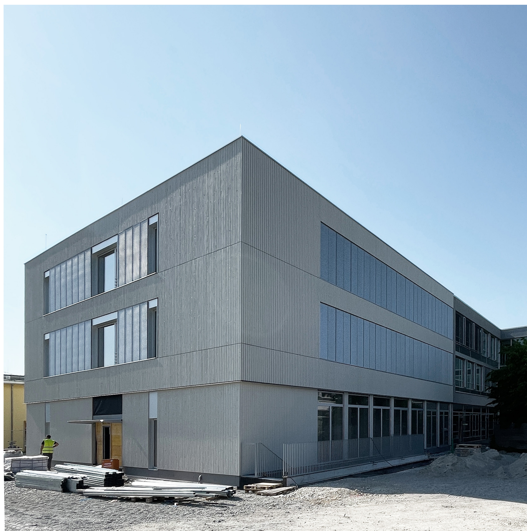
Neubau mit geschlossenen Sonnenschutz-Elementen
