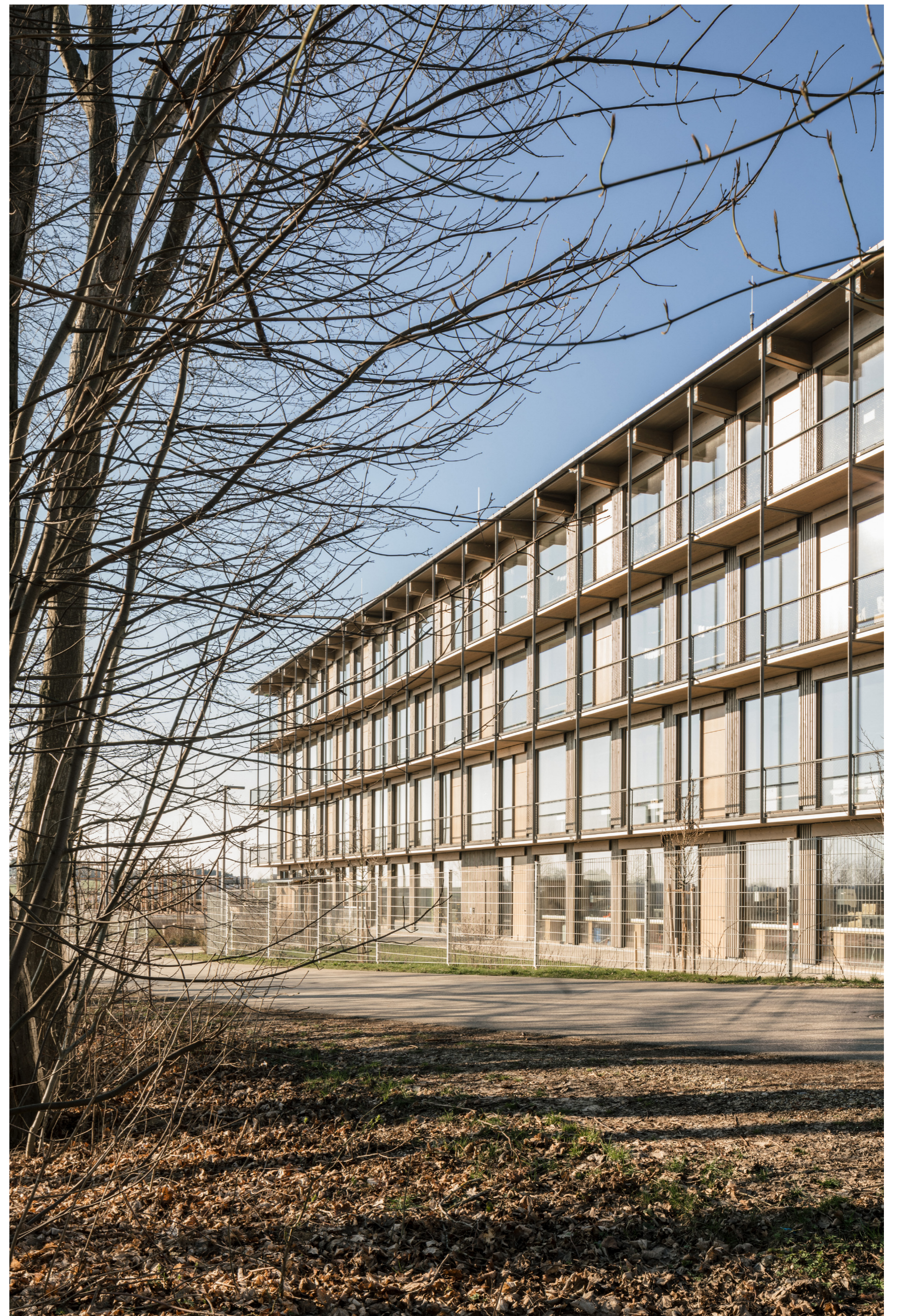
Blick auf Südfassade
