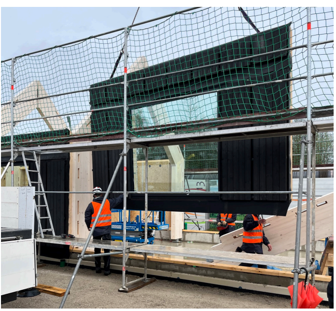
Montage der Holzbauelemente auf der Baustelle
