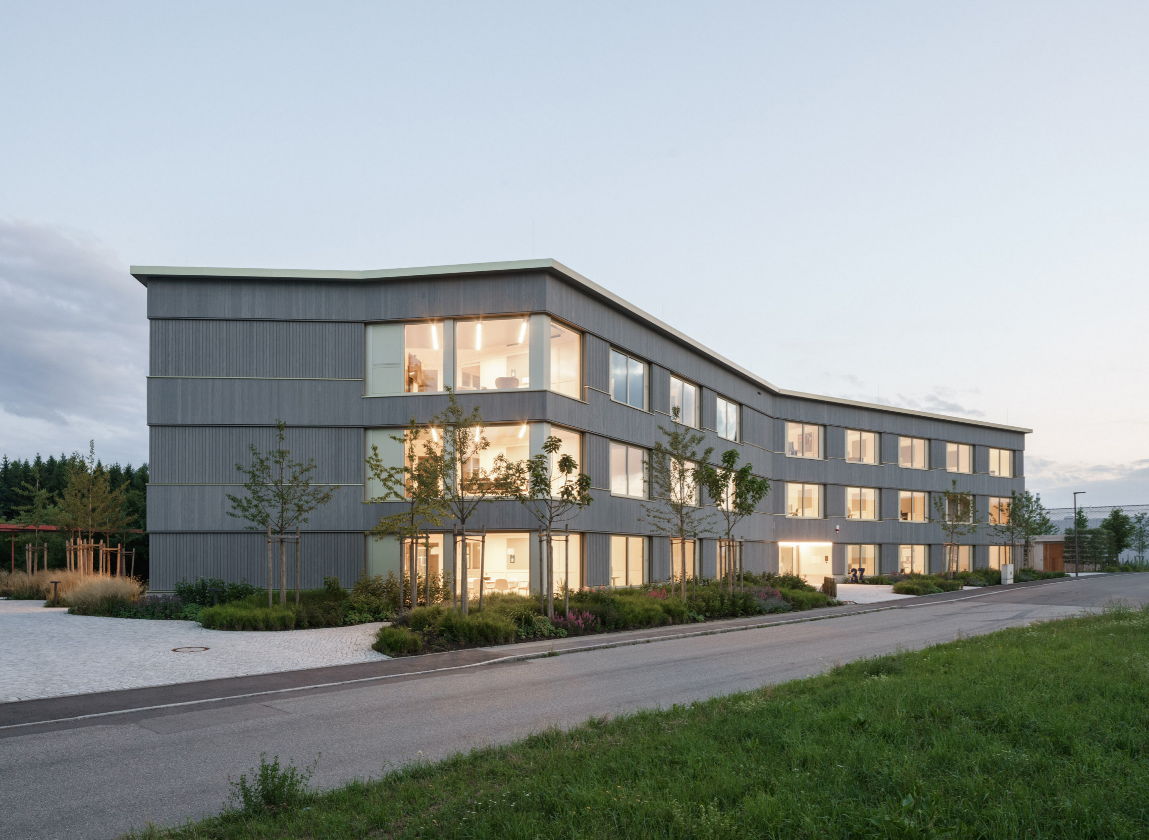
Firmenzentrale CADFEM Gruppe im Gewerbegebiet Schammach
