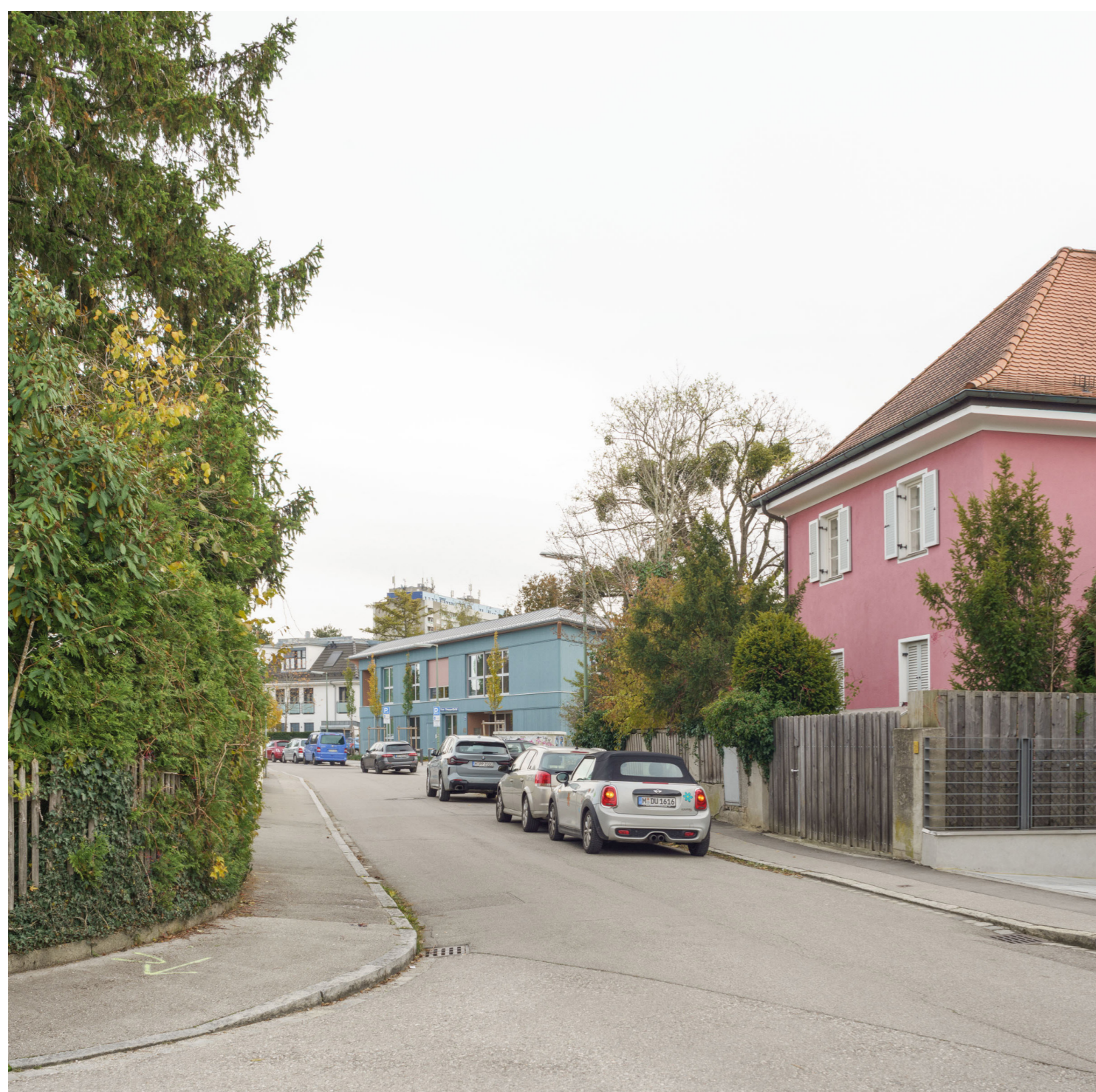
Kinderkrippe im Kontext des Wohnviertels München-Hadern
