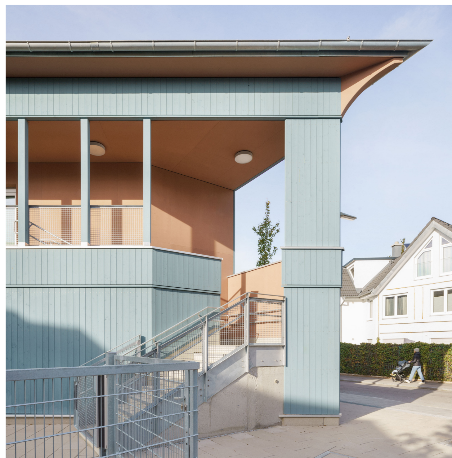
Gartenausgang Südloggia - zweiter baulicher Rettungsweg
