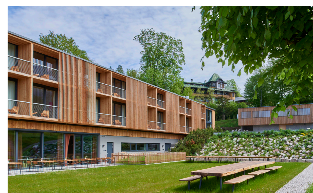
Balkon - Massivholzbalkonstruktion mit Spalierleisten aus Lärchenholz als Sichtschutz
