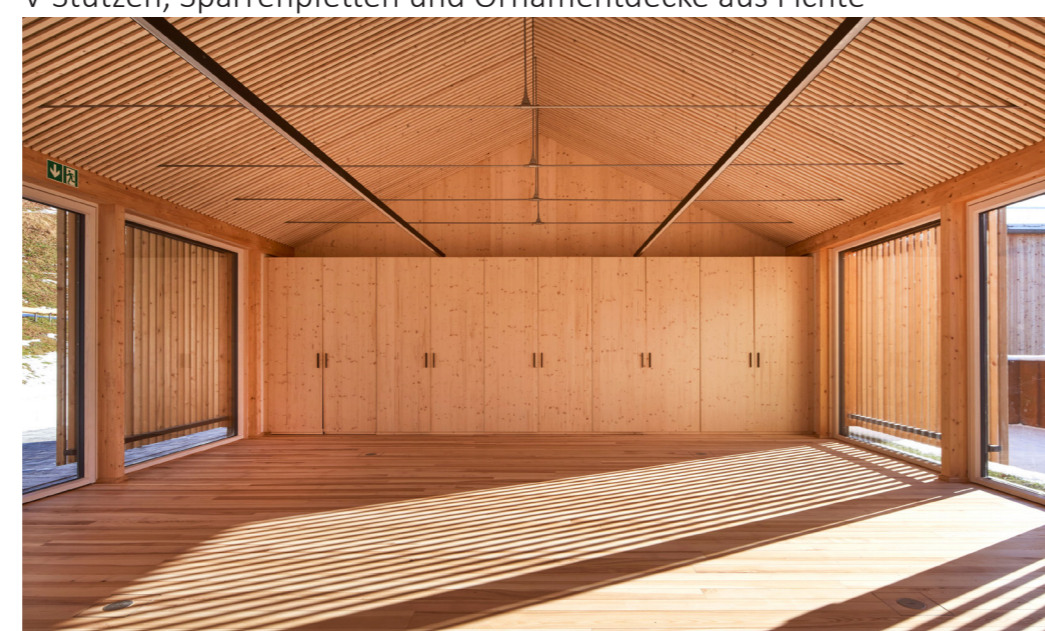
Atelier - filigranes, stützenfreies Dachtragwerk mit Akustikdecke aus Fichtenleisten und Hanfdämmung
