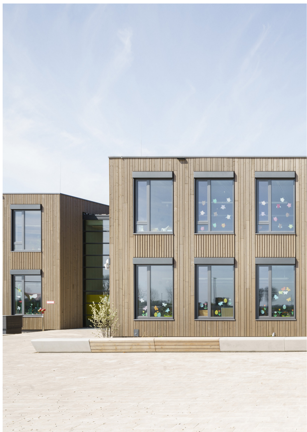
Fassadenstrukturierung durch verschiedene Breiten der Schalbretter
