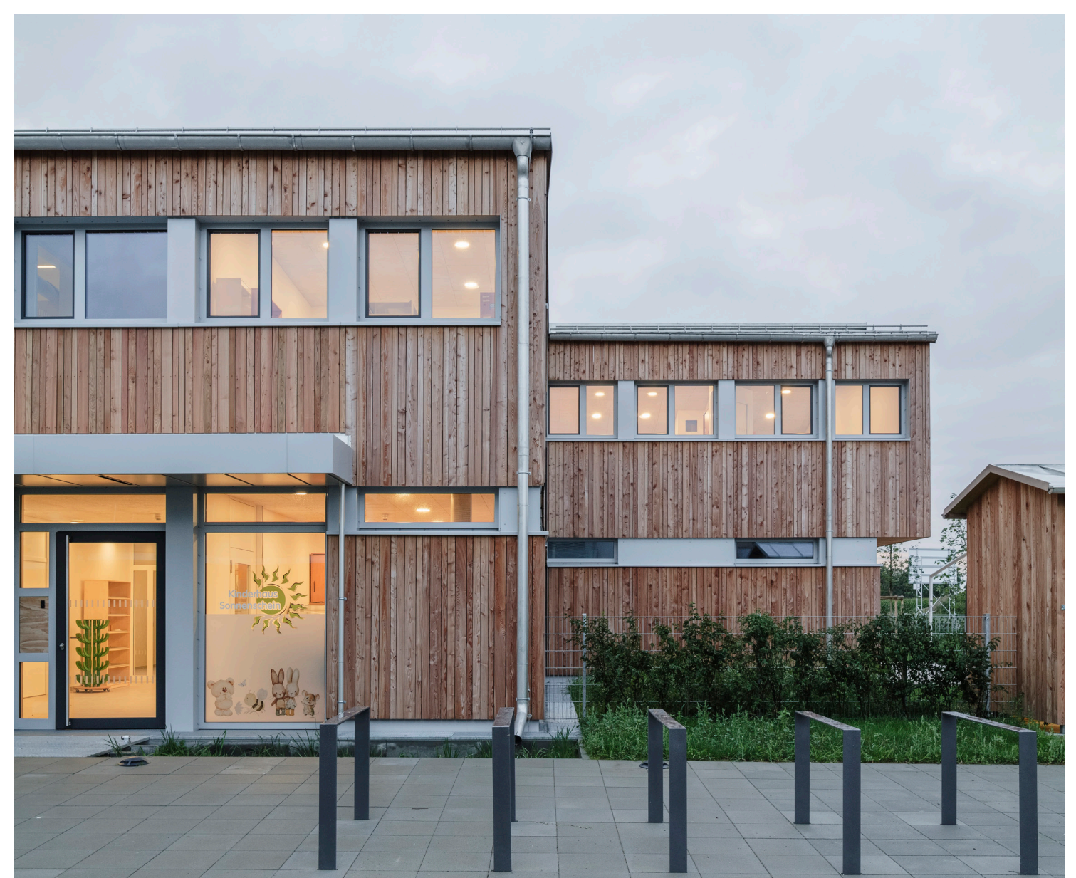
Ansicht von Norden / Haupteingang
